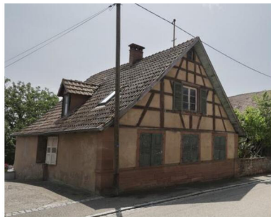
Fin novembre 2023, le maire d'Engwiller a annulé le permis de démolir d'une maison alsacienne située au 23, rue Principale. Photo Thomas Toussaint
